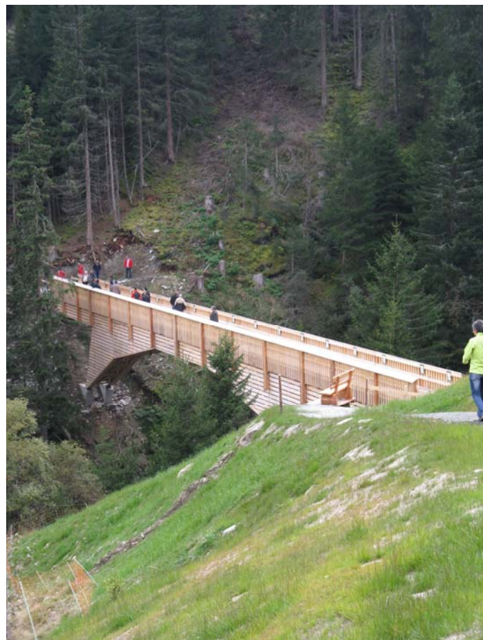
Besichtigung der Brücke Punt Val Mulin
